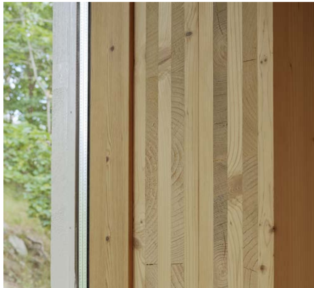
Yttervägg av KL-trä.
