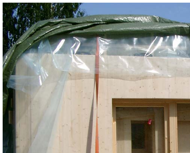
Prefabricerade väggelement på väg att avtäckas.
