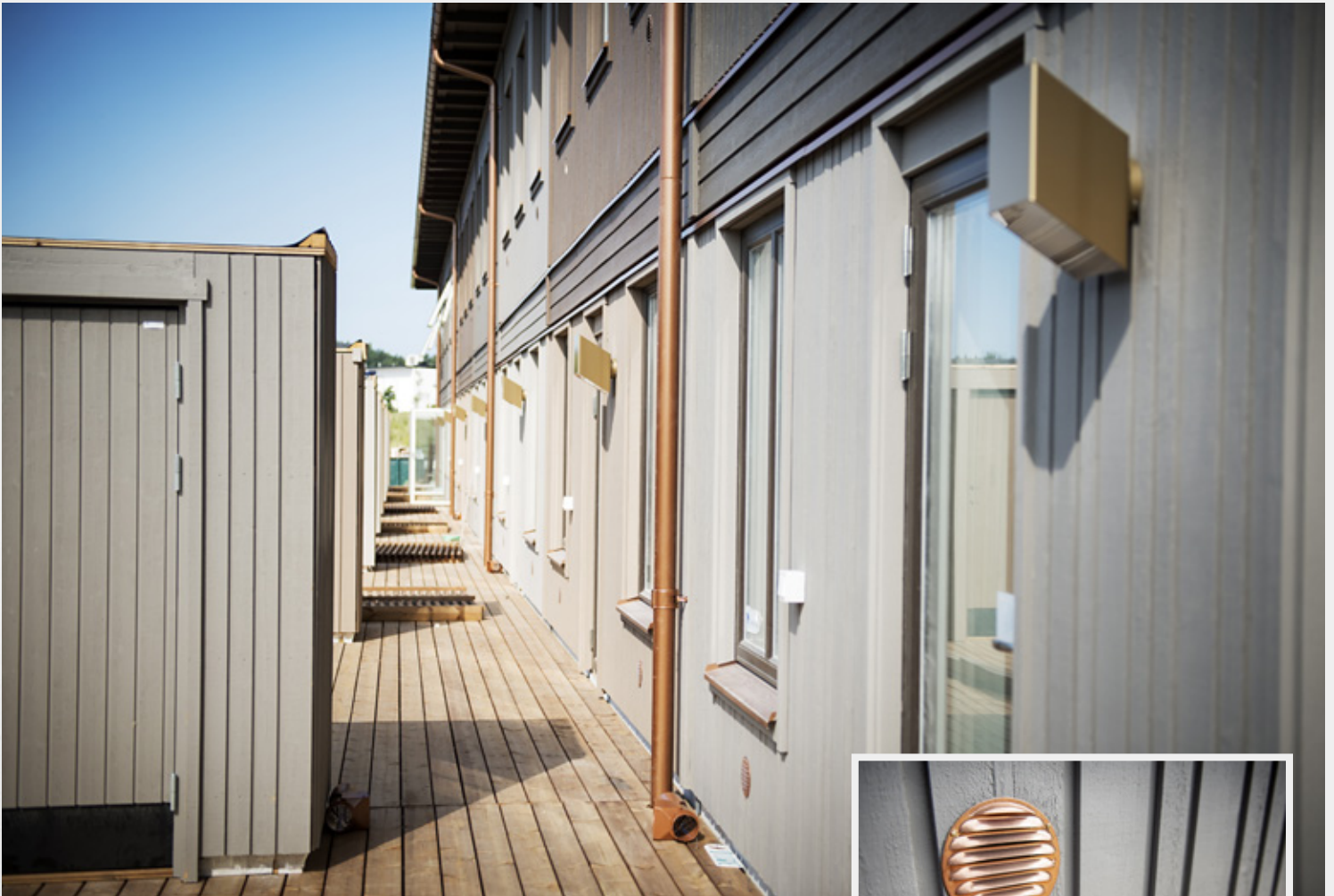
De nitton Plusshus-modulerna som uppförts i Barkarby väster om Stockholm har fått en egen karaktär tack vare individuell färgsättning och en för området speciellt framtagna utomhusarmatur.
