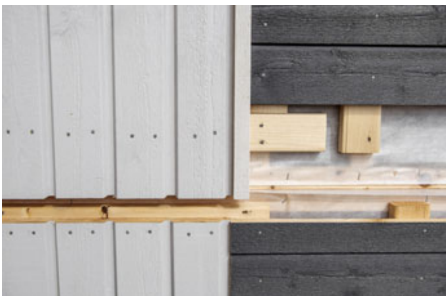
Blockskarvarna döljs med mellanstrukna bräder för att ge fasaden den rätta finishen.
