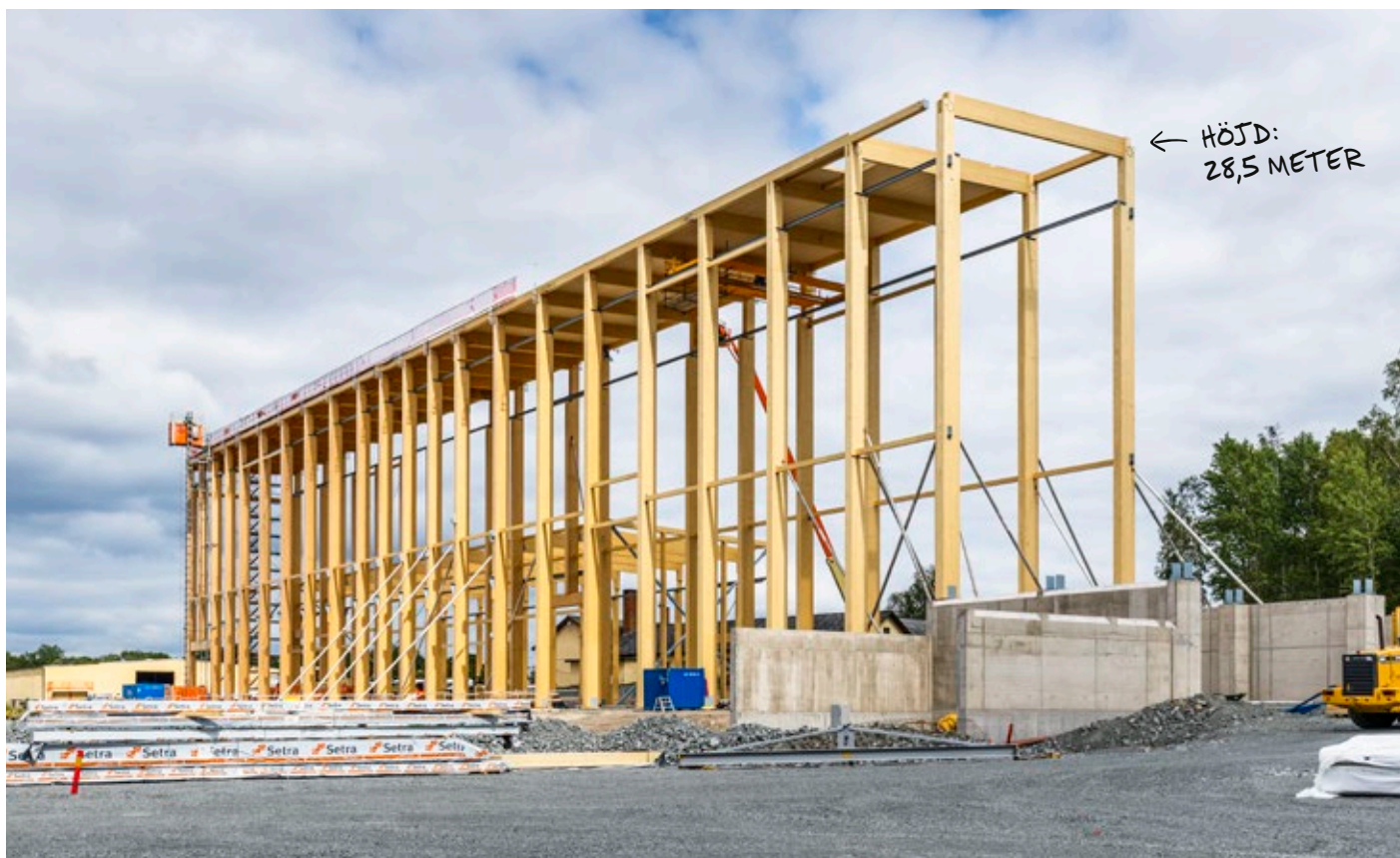
Limträstommen till den nya anläggningen i Hasselfors är Setra Långshyttans överlägset största projekt hittills.
