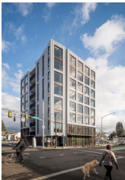
Flerbostadshuset Carbon12 i Oregon anspelar på träs förmåga att binda kol och har fått stor uppmärksamhet i USA med sin stomme av korslimmat trä.
