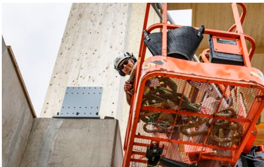
Många beslag och infästningar som används i konstruktionen är specialdesignade.
