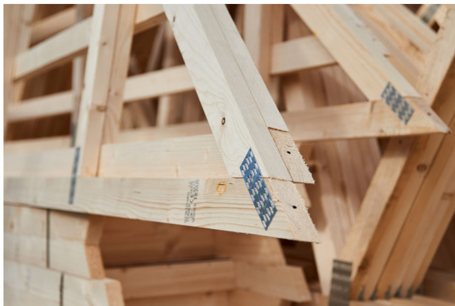
Vid hållfasthetssortering väljer man ut det virke som uppfyller kraven för bärande konstruktioner.
