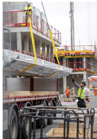
KL-träet lastas av och lyfts direkt till den plats där det ska monteras.
