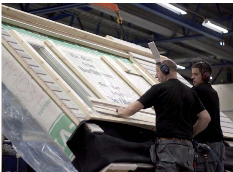
Personalen på Plusshus fabrik i Renholmen tillverkar både husmoduler och panelement.
