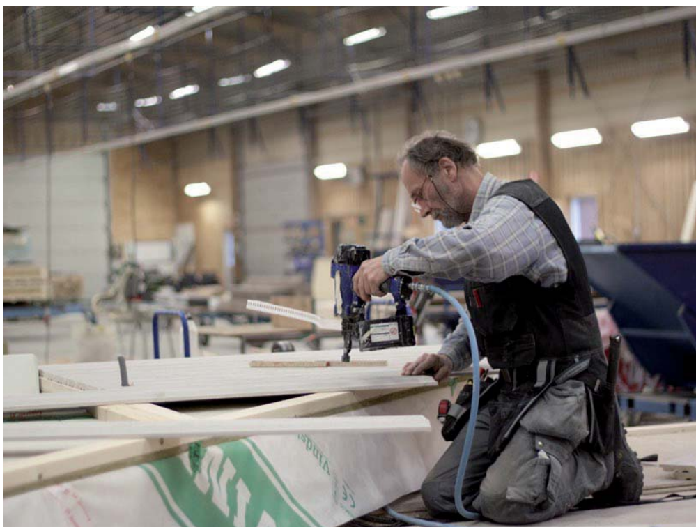
I fabriken färdigställs planelementen i en torr och säker miljö. Här monteras fasadpanel på planelement till ett radhus.
