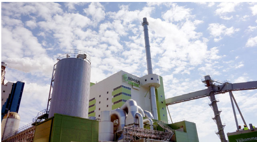
Bomhus Energi är ett toppmodernt kraftvärmeverk som bland annat förses med bränsle från sin närmaste granne Setra Kastet.
