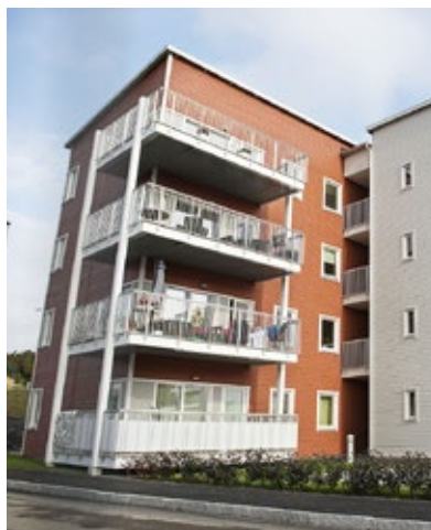
Bostadshus i kvarteret Sågen i Knivsta norr om Stockholm, levererade som moduler av Plusshus.
