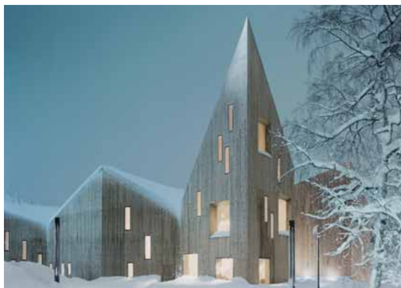
På det nybyggda Romsdalsmuseet i Molde är både tak och väggar klädda med MøreRoyal.
